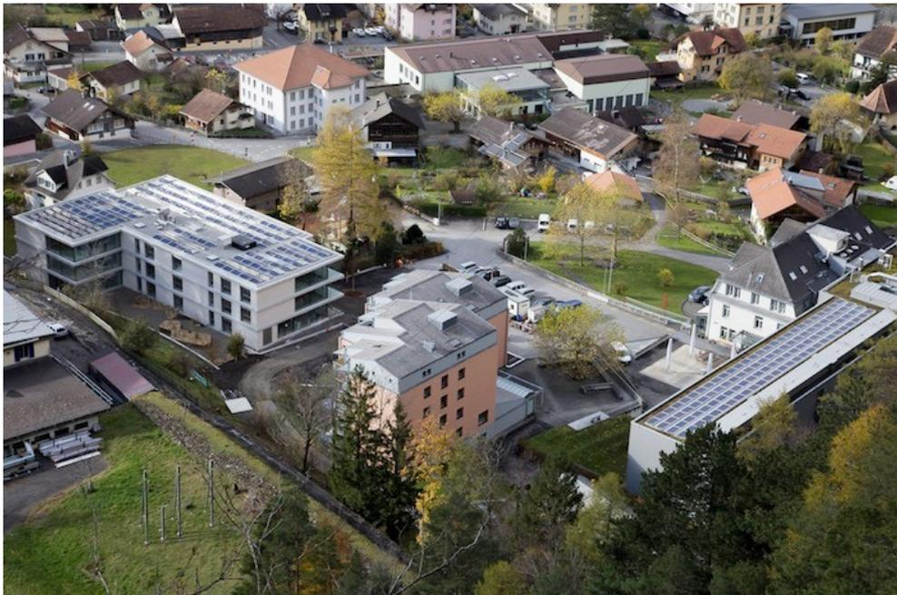
Die beiden Anlagen auf den Dächern der Stiftung Alpbach in Meiringen verfügen zusammen über eine Nennleistung von rund 103 Kilowatt.
